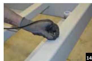
Minimale dikte van 40 µm
